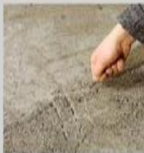
Nedovoljna tvrdoća površine
